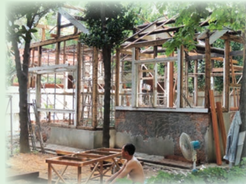
小白屋整修中
